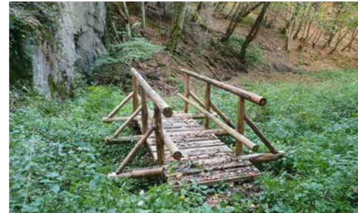
Le pont restauré au lieu-dit Waldmatten
